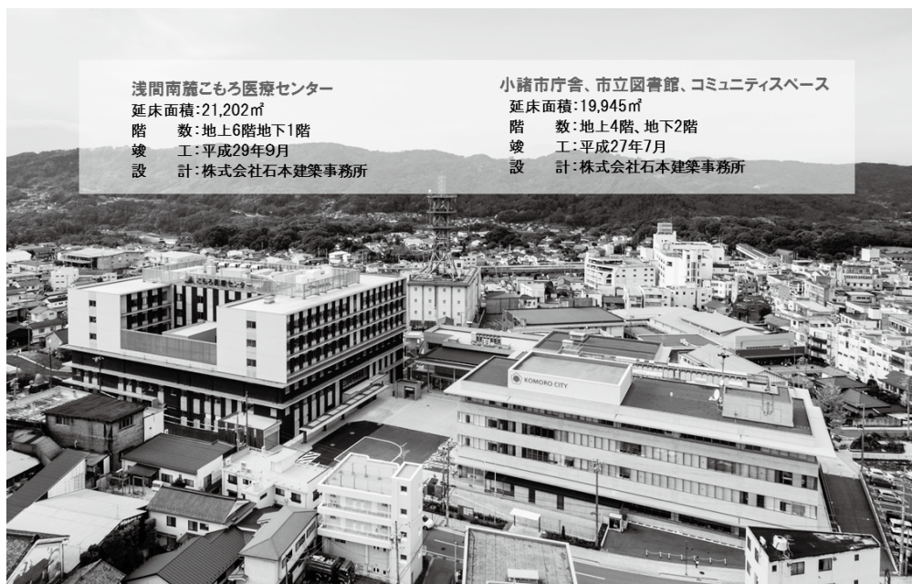
写真1 小諸市庁舎等および浅間南麓こもろ医療センター
