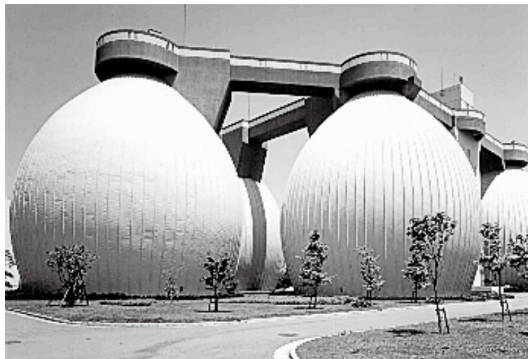
写真1 卵形消化タンク
