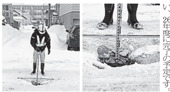
写真6 マンホール蓋上の融雪段差
