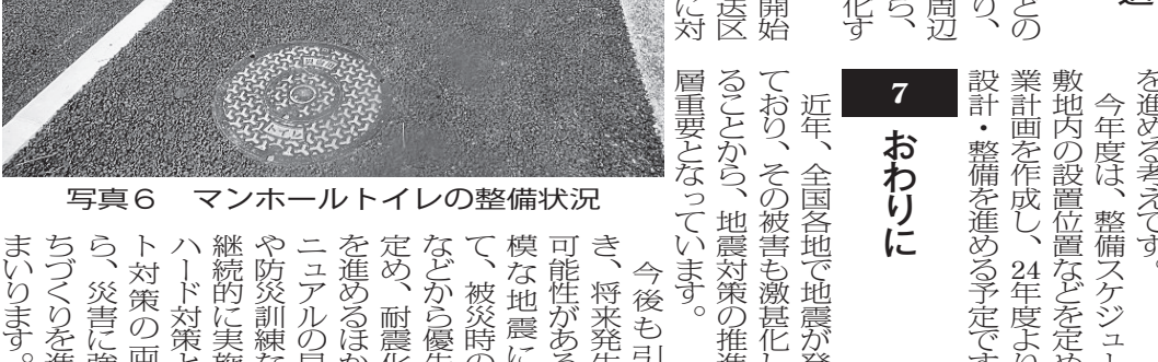
写真6 マンホールトイレの整備状況
